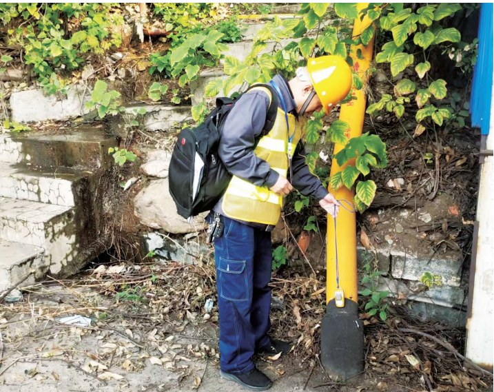
图为攀枝花华润燃气有限公司巡检员巡检检测(城郊)中压燃气管道。
