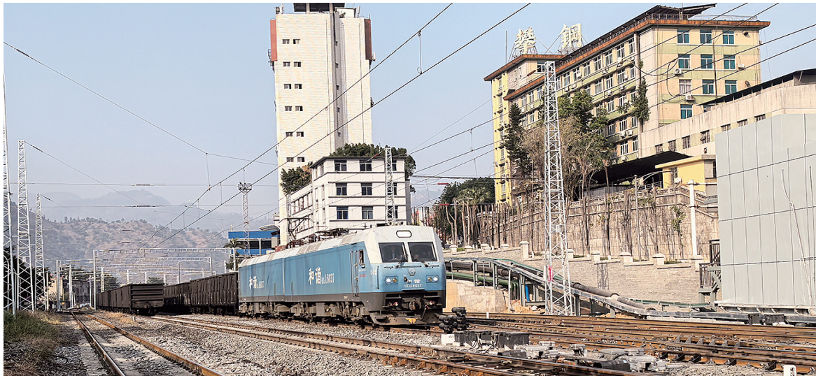
攀钢电气化专用线正在运营。
