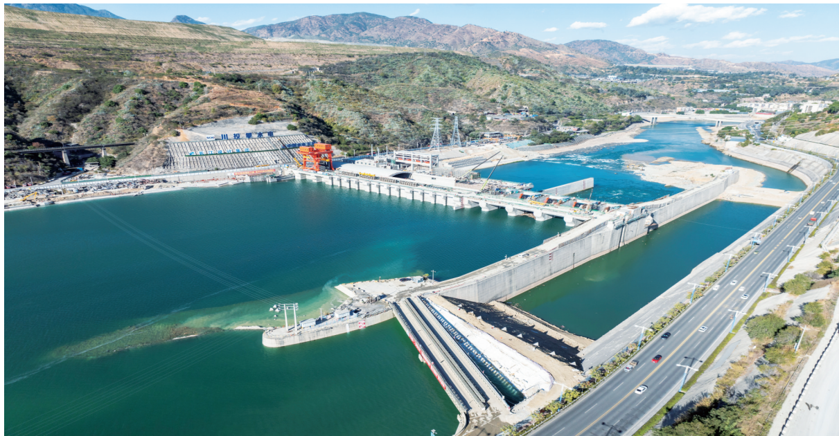
银江水电站航拍图。
