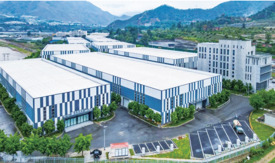
图为四川昂世新材料科技有限公司厂区。
