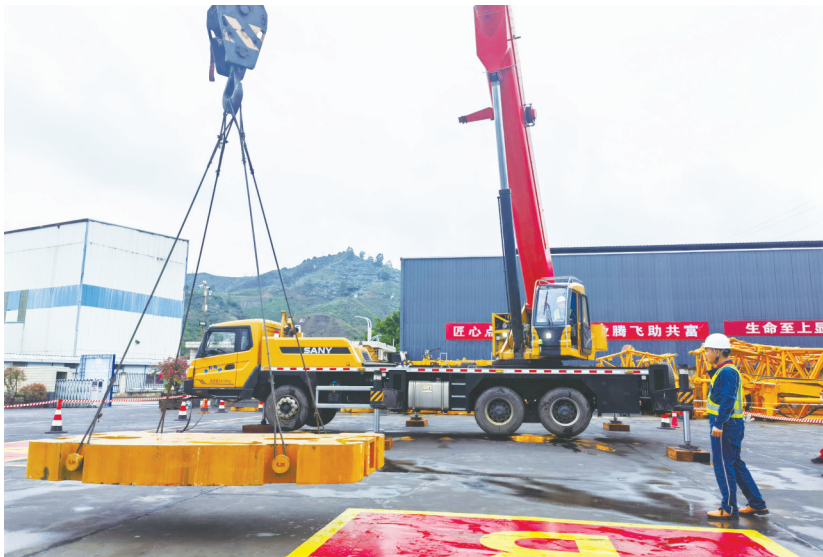
图为汽车吊装技能竞赛现场。
