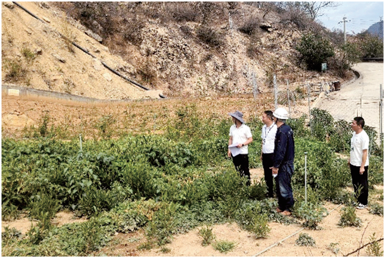
开展现场勘査。
