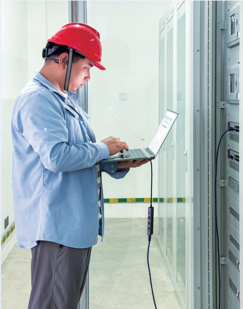
工作人员正在对12MW/60MWh全钒液流储能电站数据通信管网进行调试。
