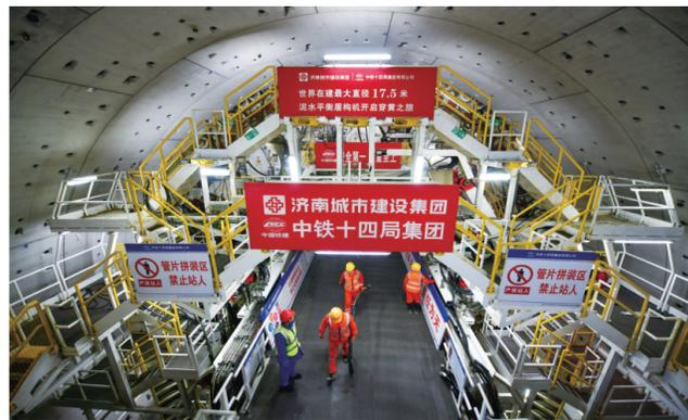
3月4日,中铁十四局建设者在济南市黄岗路穿黄隧道盾构段作业。当日,山东省济南市黄岗路穿黄隧道进入黄河水域段施工,隧道盾构段已累计掘进1658米,开挖过半。济南市黄岗路穿黄隧道全长约5755米,其中盾构段长约3290米,盾构机开挖直径17.5米,是目前在建的世界最大直径水下盾构隧道。(新华社记者 朱峥 摄)
