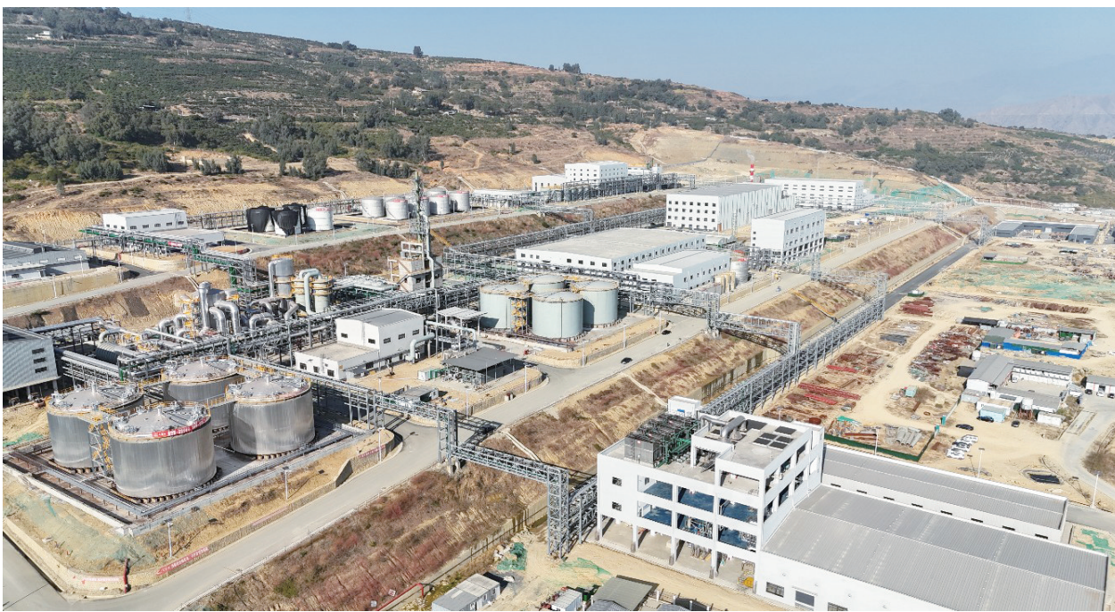
攀枝花龙发新材料项目建设现场。(市融媒体中心记者 郑星 摄)
