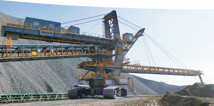
无人化排土生产线。
