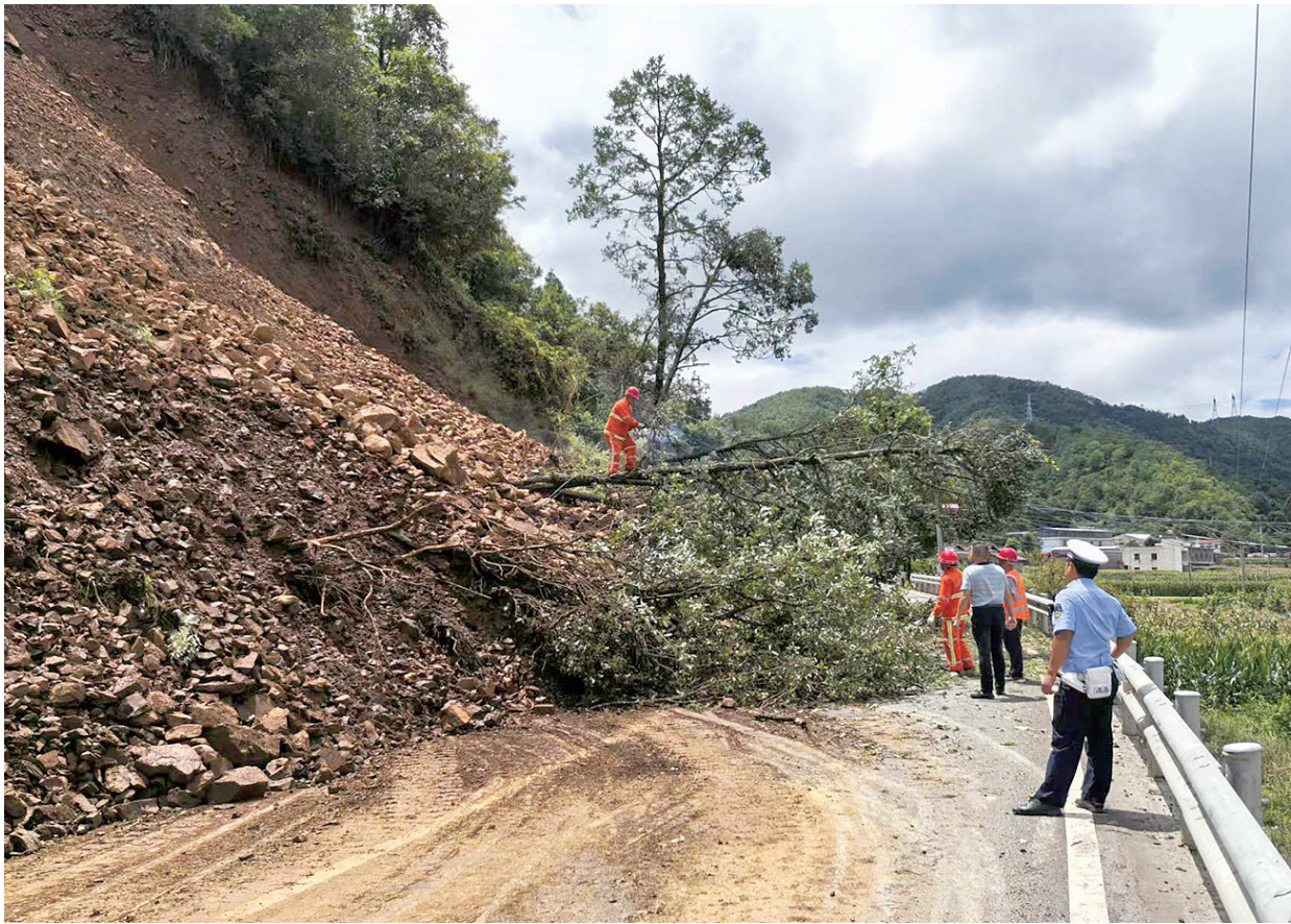
图为公路抢险人员清理边坡和树枝。
