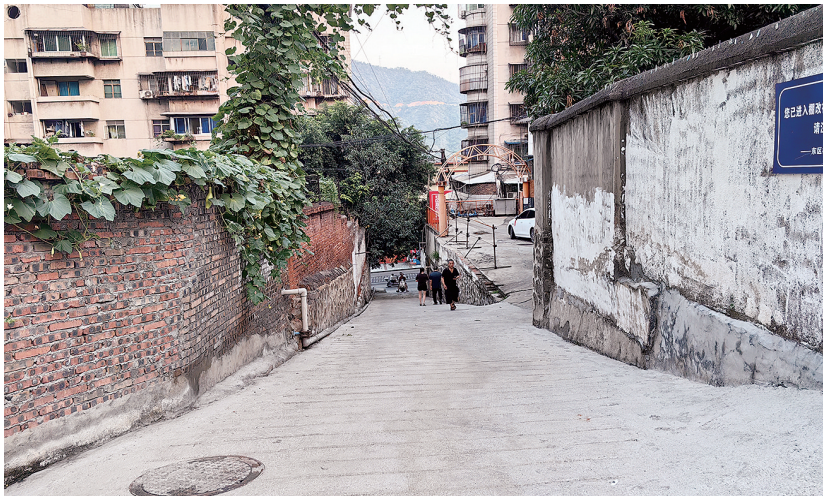
图为改造后的水泥路。
